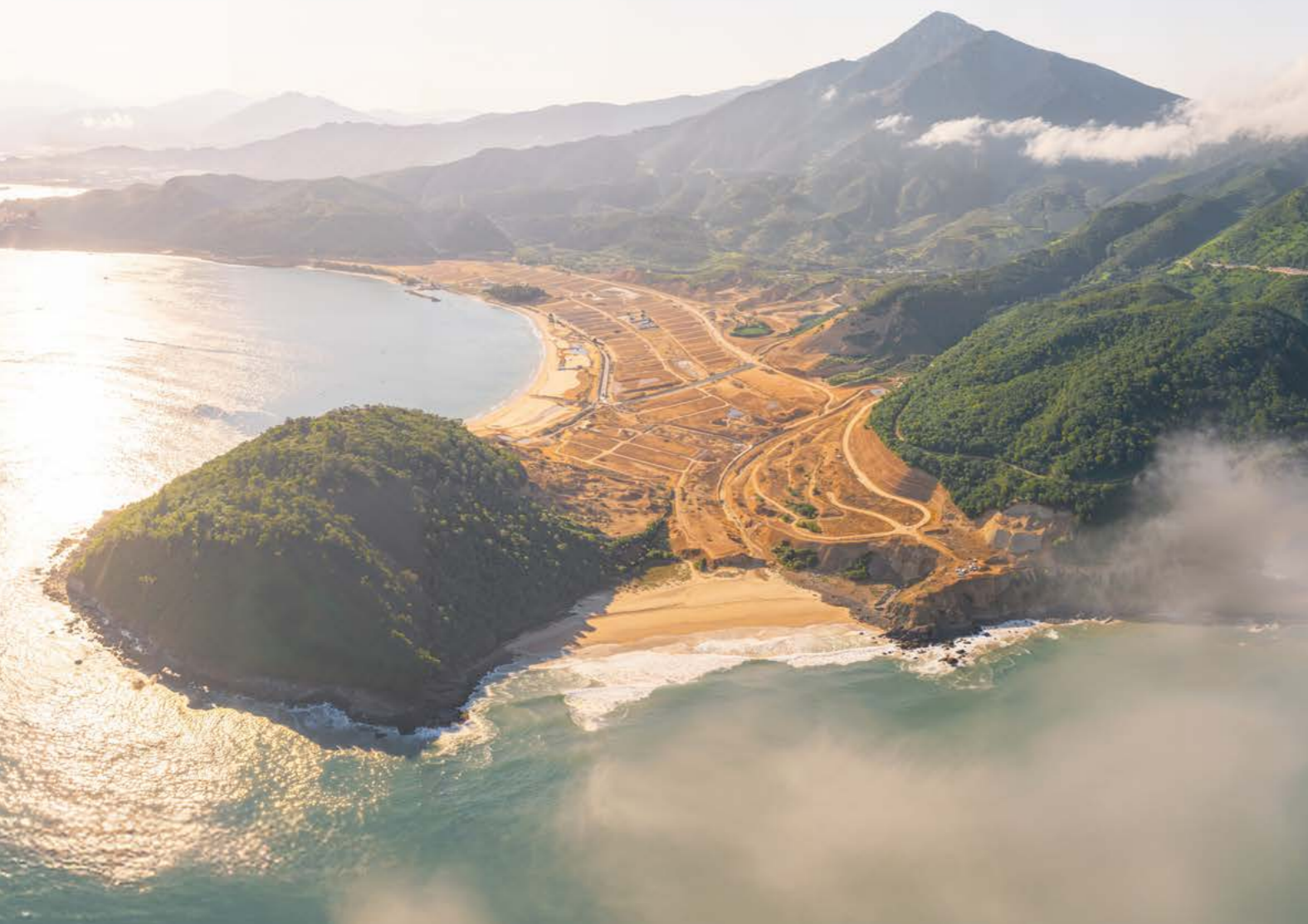
Công trường dự án Lăng Vân
